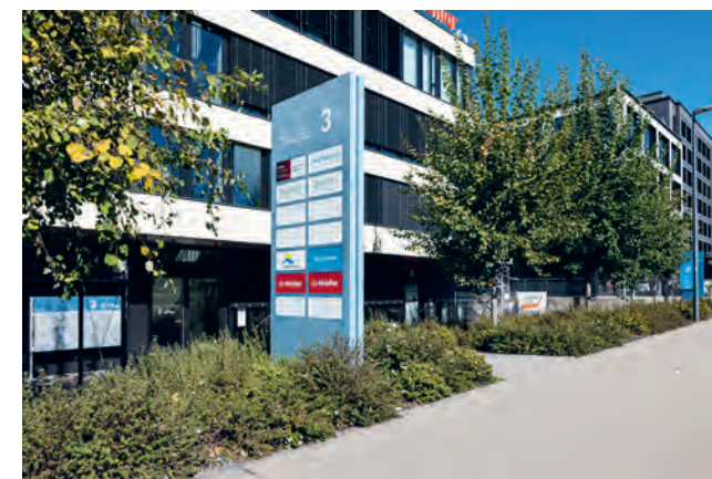
An der Obstgartenstrasse 3 in Affoltern entsteht das neue Dialysezentrum.
